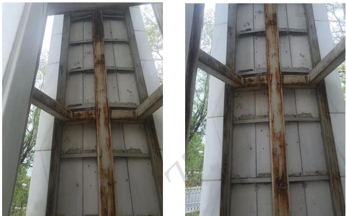
**四项：**大理石及黄岗岩损裂修复更换，字体连接件修复更换，石缝及连接处原石材胶清除处理，重新涂装加强胶与石材胶。
